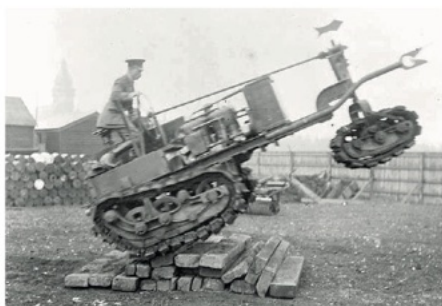
Demonstratie van de Killen-Strait tractor over bielzen en door prikkeldraad.
